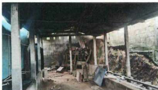
Foto 5: En esta fotografía del módulo 3 se observa el deterioro de las columnas, vigas, costaneras y laminas.
