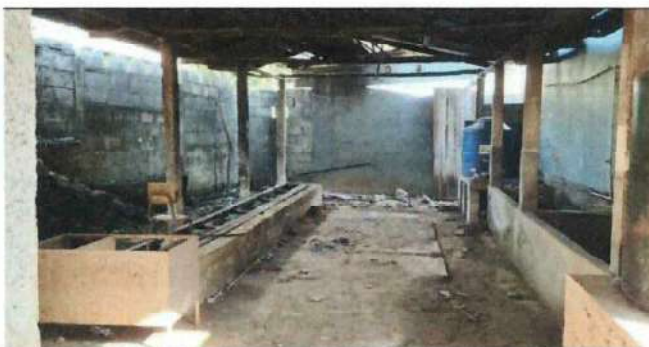
Foto 6: En esta fotografía del modulo 3, se procederá a tirarle torta de cemento de 72 metros cuadrados.
